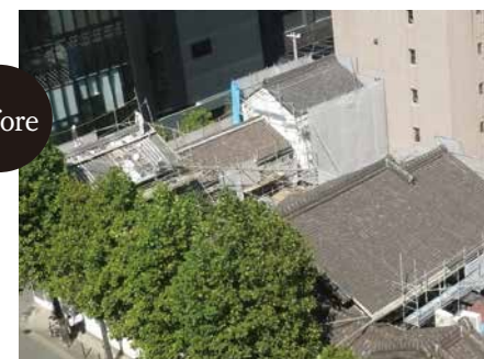
修景工事中[屋根部]
