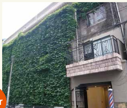
修景後 設備機器を撤去し、テラスを新設
