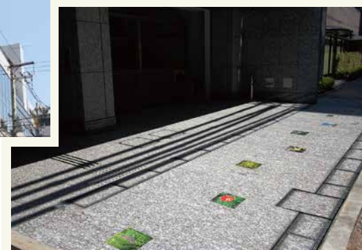
修景後[オープンスペース]
