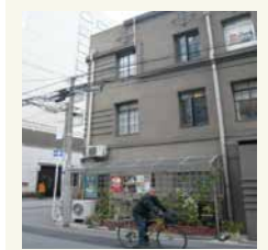
修景前[西側壁面]
