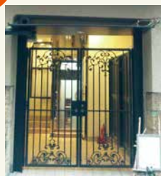
飾り扉の設置
