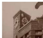
完成当時の時計台
