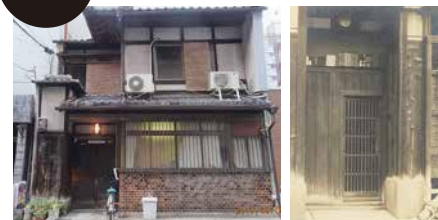
工事前の写真
