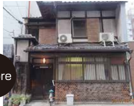
工事前の写真
