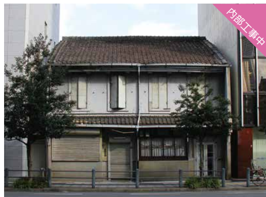
工事前の写真
