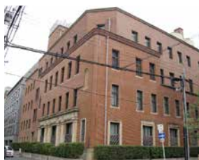
建物全景(修景前)
