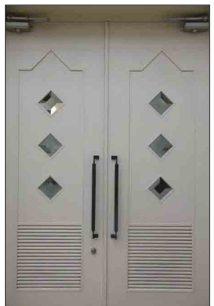
上 :3、4階階段踊り場 下 :地下1階開平ホール入口扉の面取り透明ガラス
