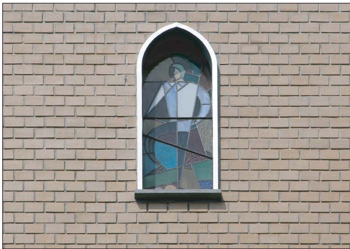
堺筋側から見たステンドグラス
