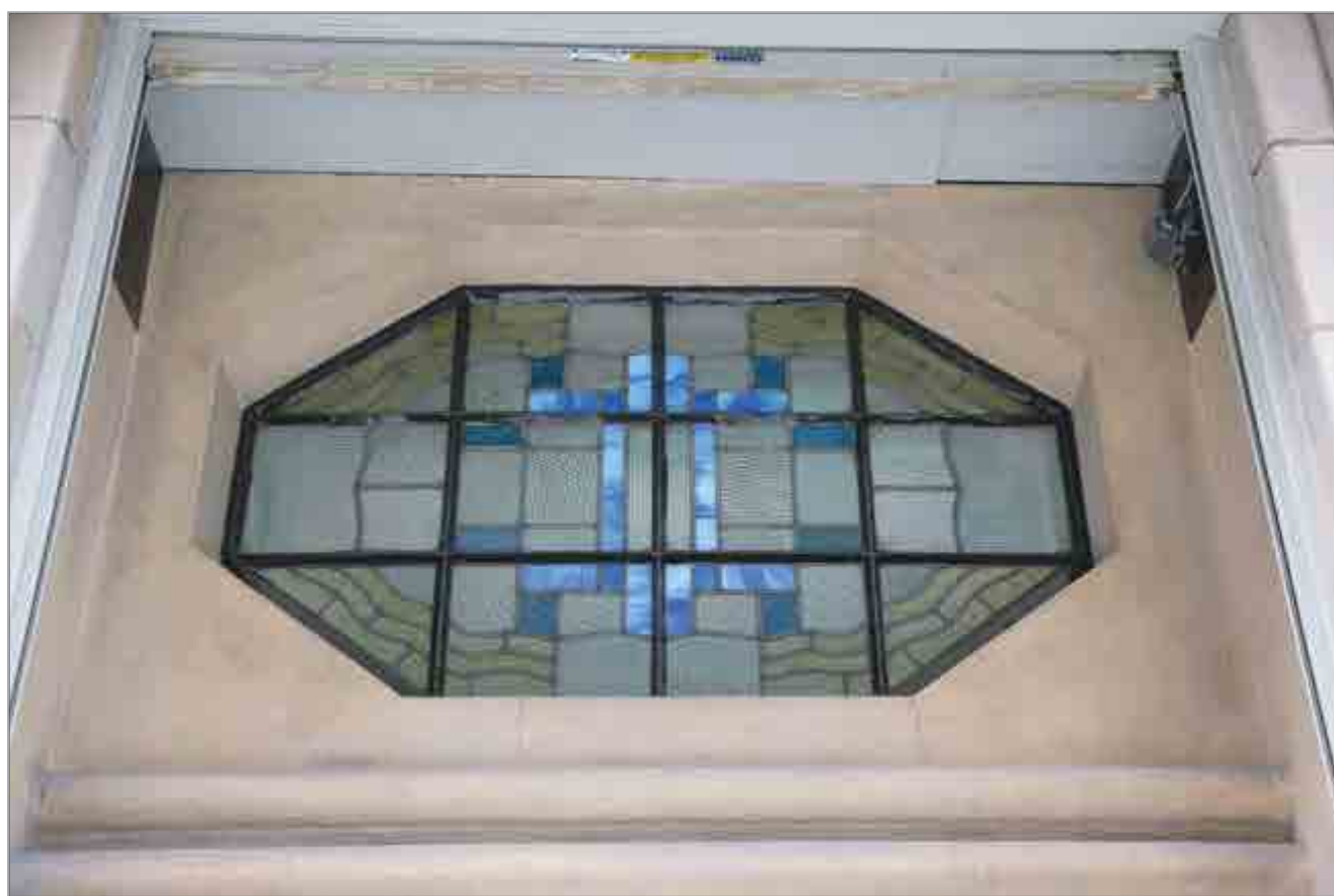
左: 正面玄関横 階段室入口扉上部嵌め殺し窓のステンドグラス
