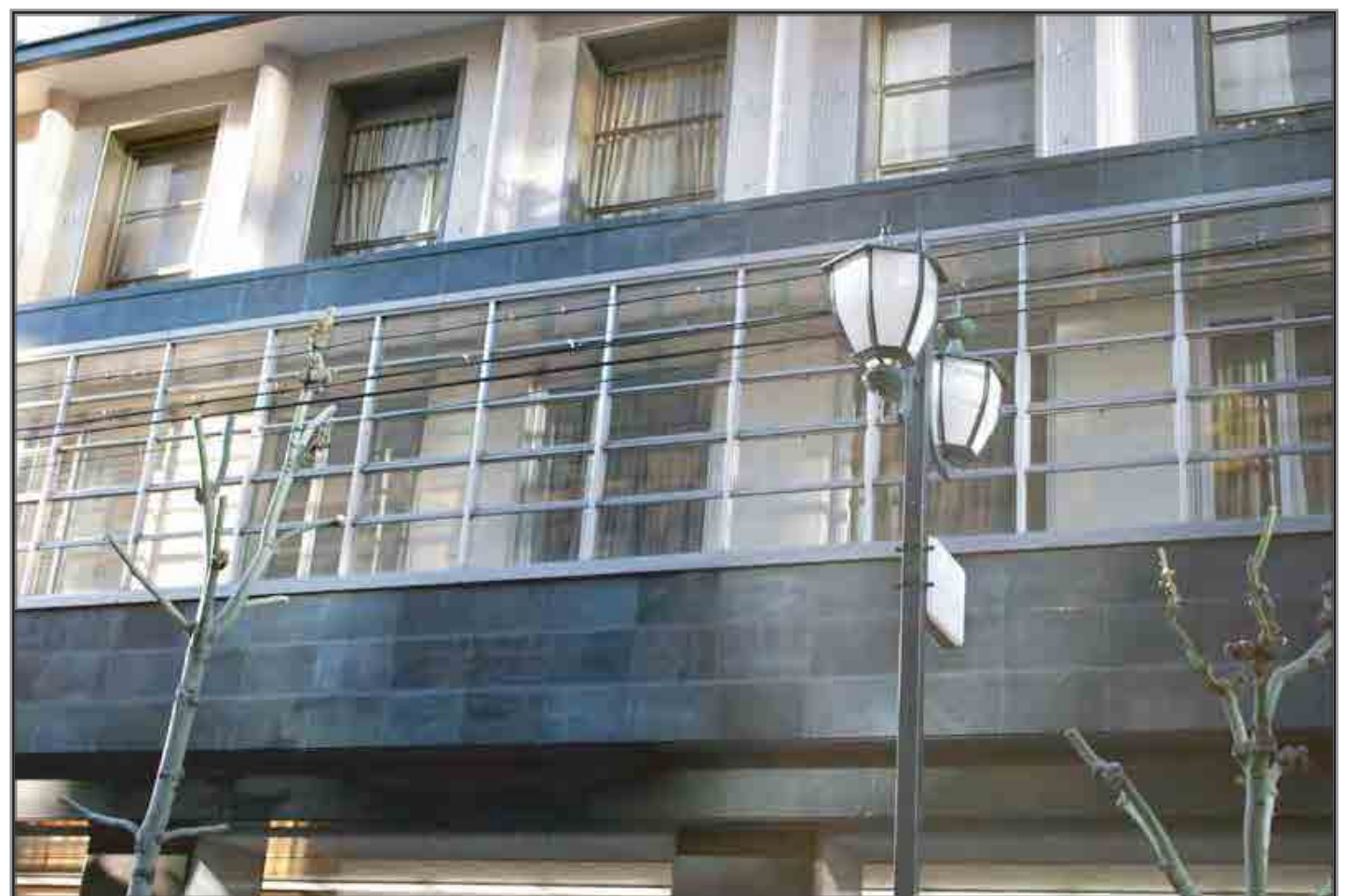
現在の外壁の様子
